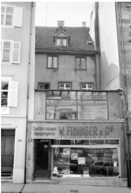
BILD 11 | Das Gebäude an der Bäumleingasse 14, mit dem im Vordergrund stehenden Laden, vor der Renovation.
